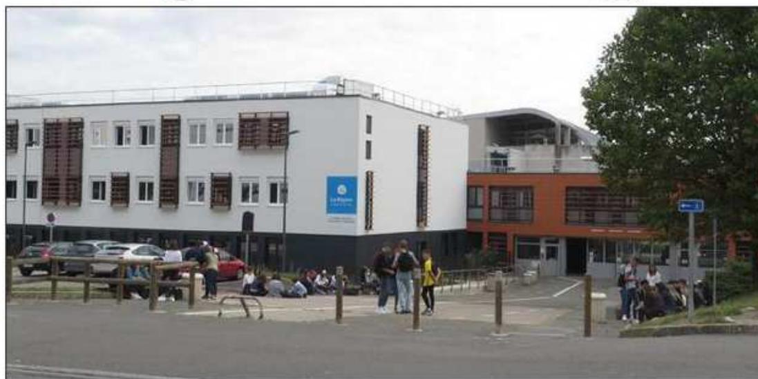
■ Les travaux vont se poursuivre jusqu'en 2021. Photo Jonathan BREUIL
